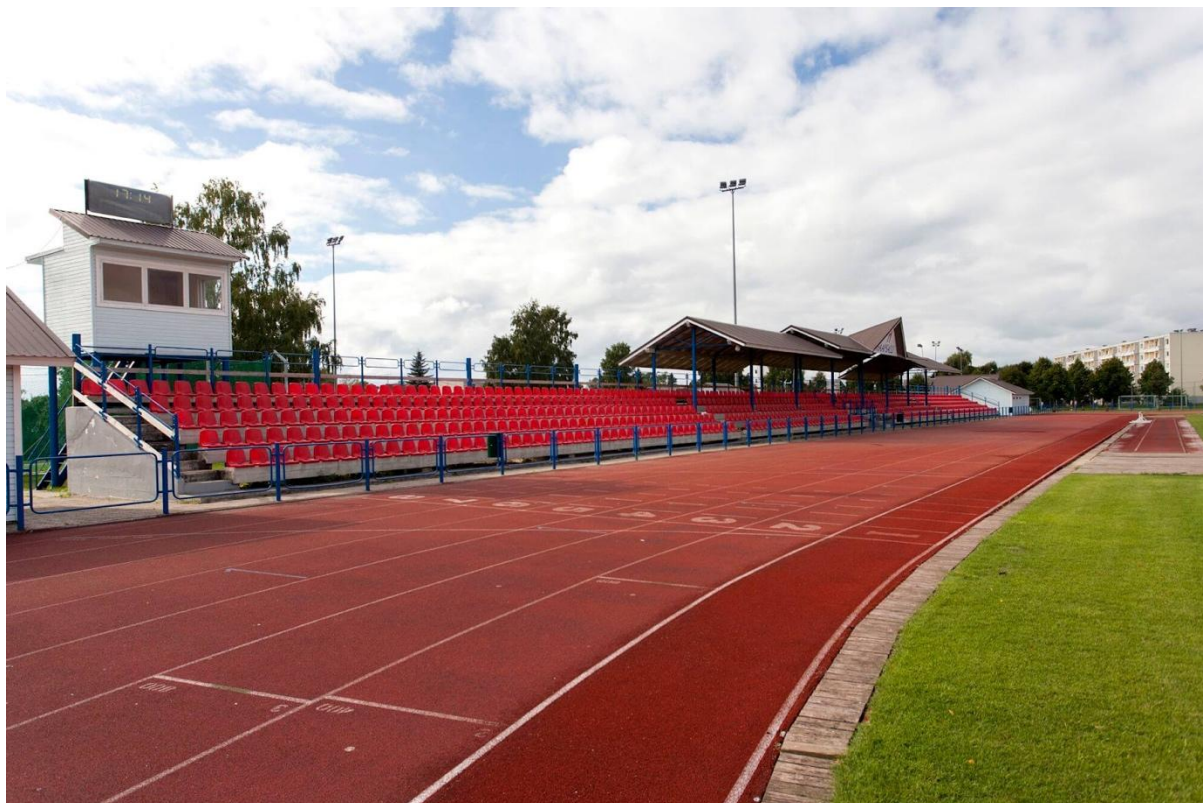
Haapsalu staadioni renoveeritud siserada. Foto: Haapsalu Linna Spordibaasid OÜ.
